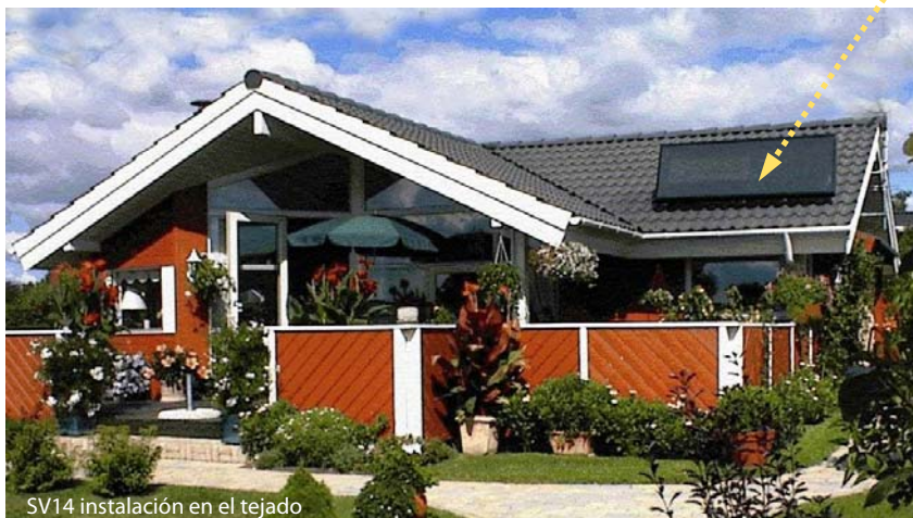
SV14 instalación en el tejado
